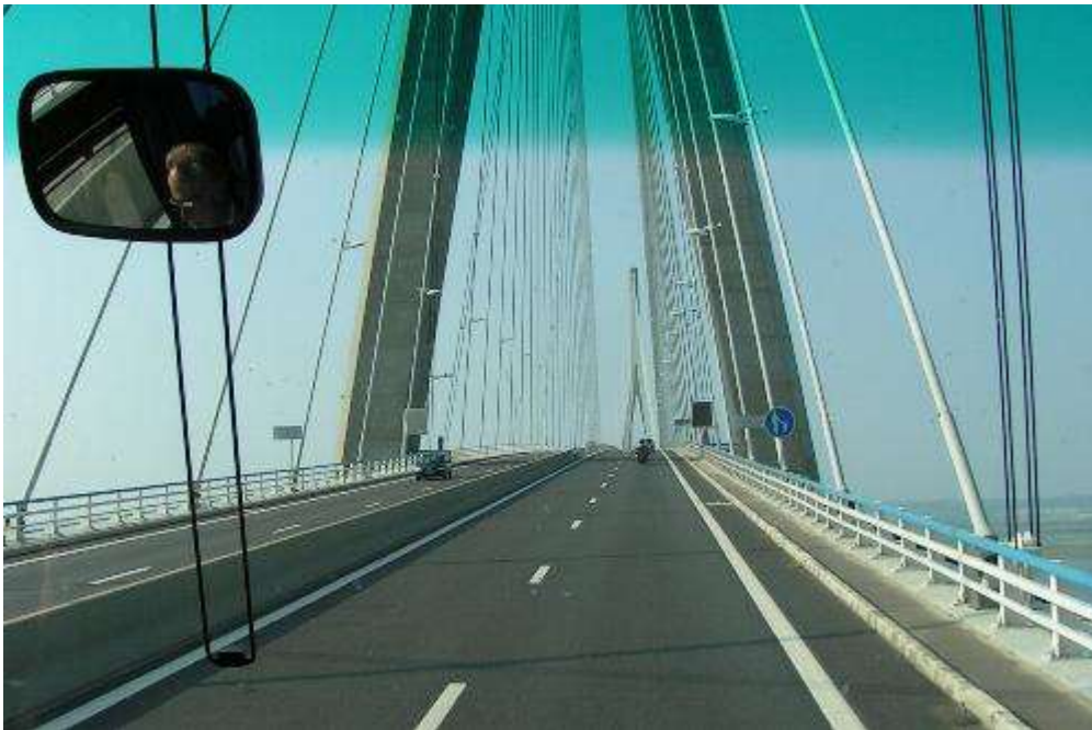
Pont de Normandie
